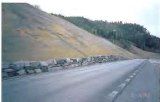
Fig. 24: Sikring av skjeringsfot med tørrmur ved Bolstadøyri.
